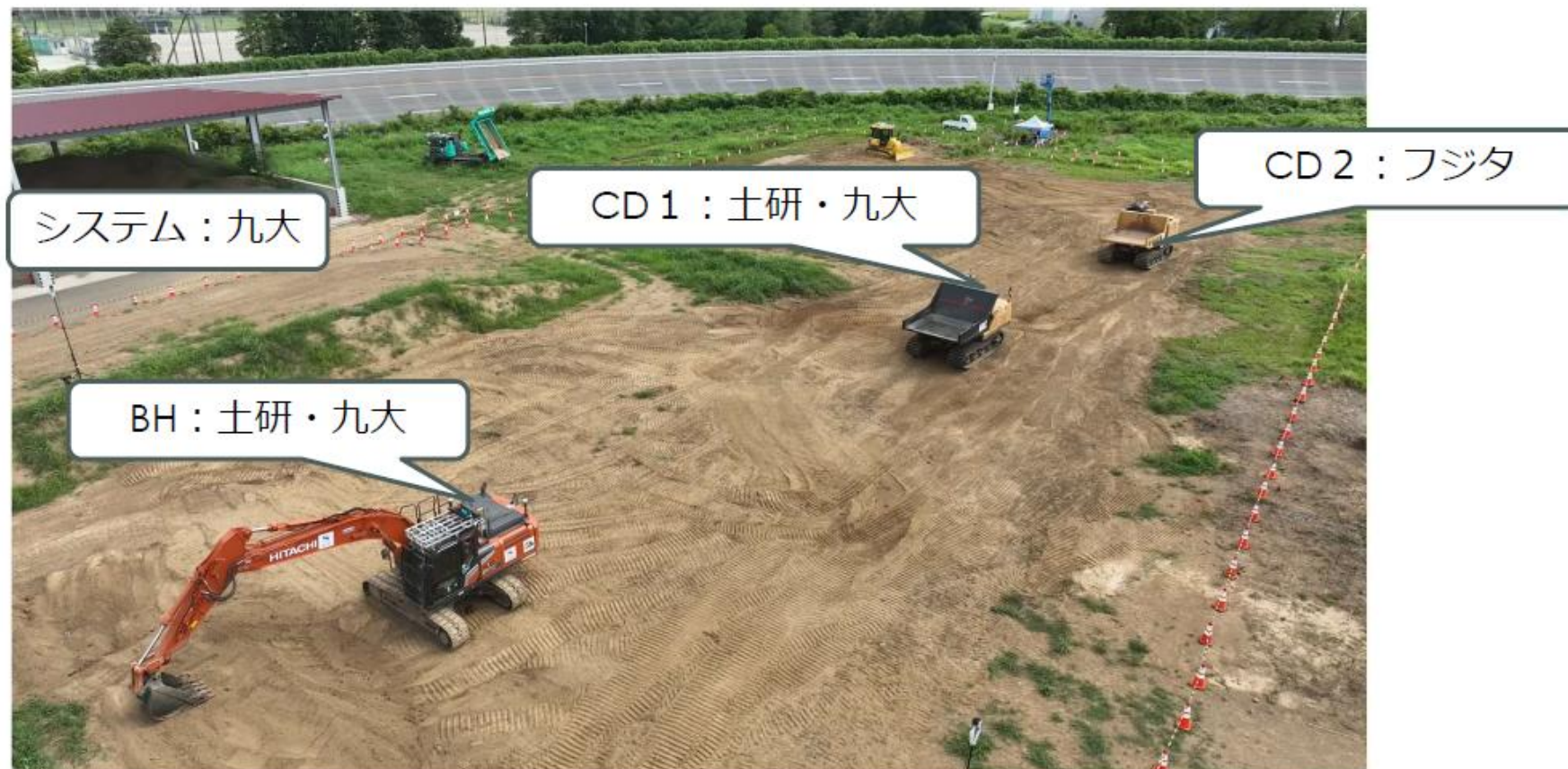
試験ヤードでの模擬施工
