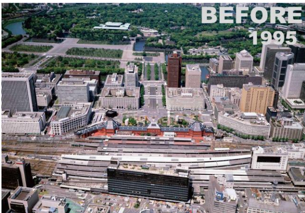
図1 1995頃の東京駅周辺のビル群
